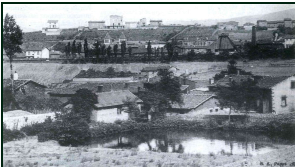
LA GRAND-CROIX : Ancien moulin à farine Chevillon (Chavillon) devenu usine Bajard. Au premier plan l'un des trois bassins pour l'alimentation hydraulique.
